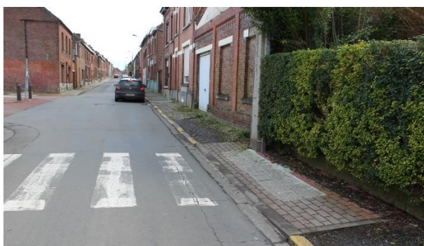
Figure 32 : revêtement discontinu nuisant à la qualité du trottoir en dépit de la traversée piétonne correctement réalisée (face à l'école de Plantis) (Agora, 2022)
