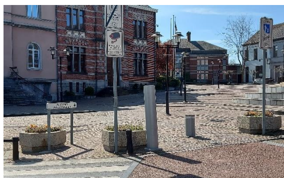
Figure 33 : accès signalé pour les PMR et bordure adaptée, sur la Grand Place (Agora, 2020)
