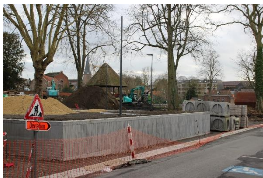
Figure 96 : travaux en cours du parc communal (Agora, 2022)
