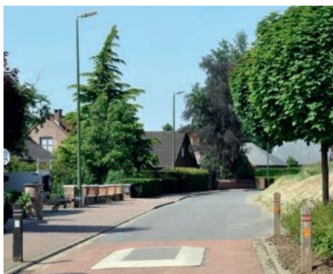
Figure 107 : Coussin Berlinois qui permet de faire passer les vélos en sécurité et sans les ralentir (Source : CeMathèque)
