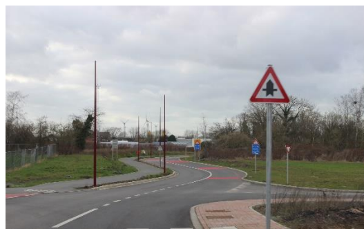
Figure 98 : tronçon du contournement de Dour (Agora, 2022)
